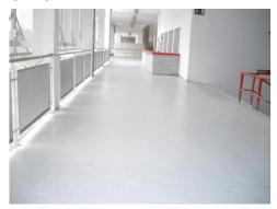
**Impermax** Polyurea двухкомпонентный гибрид это полимочевины, который отверждается в течение очень короткого времени. образуя эластичную мембрану, обладающую возможностью затягивать мелкие трещины поверхности. Данный продукт может перерабатываться только при помощи оборудования высокого давления для напыления двухкомпонентных систем (соотношение 1:1). Данный материал может применяться вместе с различными типами геотекстиля для получения бесшовных гидроизоляционных выстилающих поверхностей.
